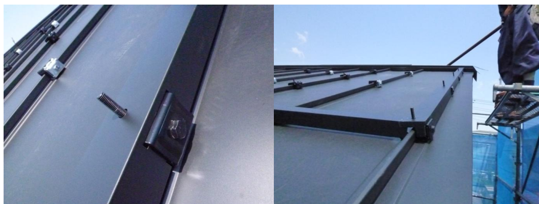
東側 ケラバ金物カバー取付状況
